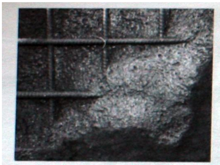
Рис. 8.12 Хорошее укрытие арматуры. Хорошее уплотнение и подходящая скорость. Обратите внимание на блеск и равномерность укладки смеси
